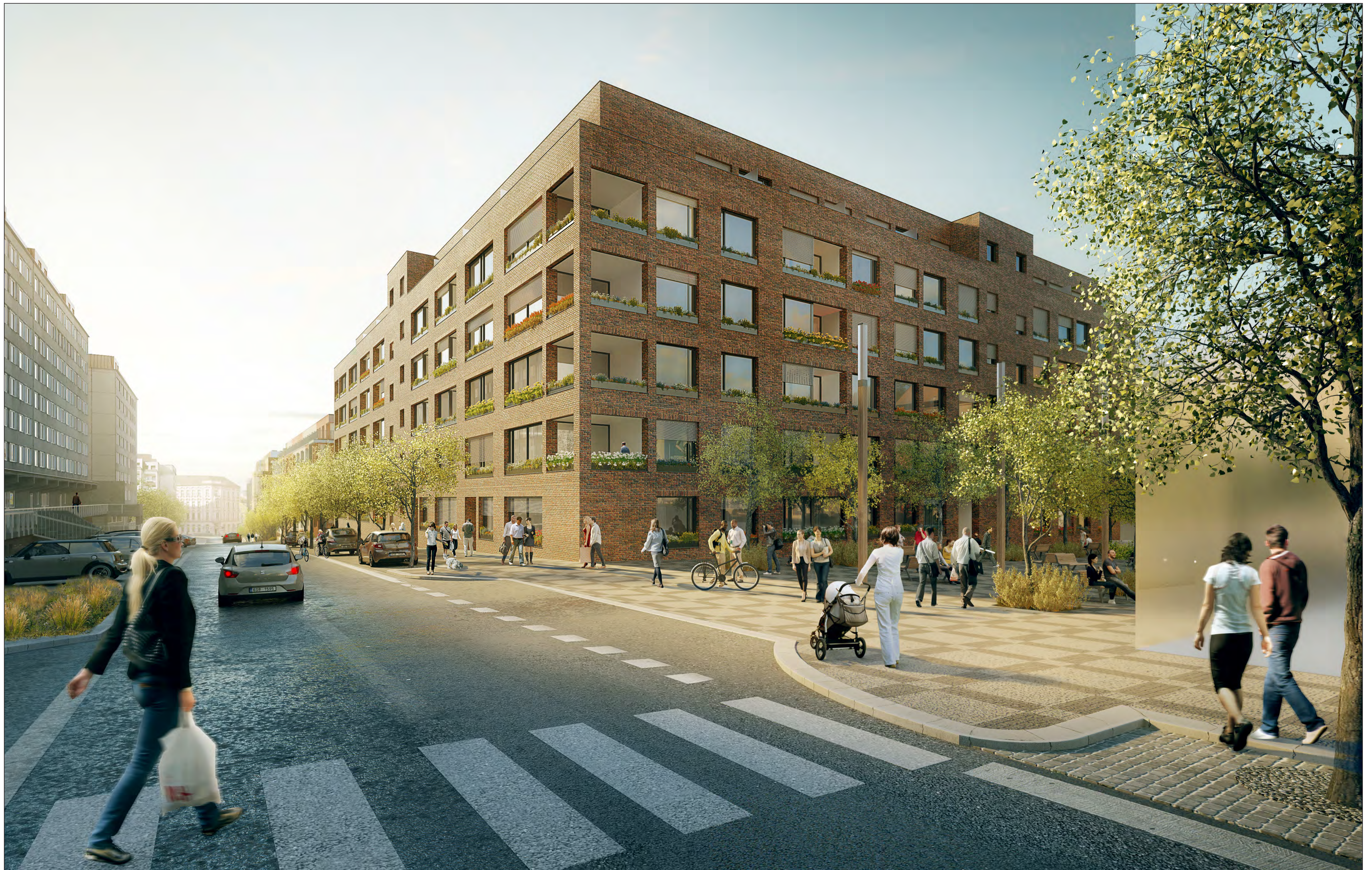
POHLED Z ULICE ROHÁČOVA
